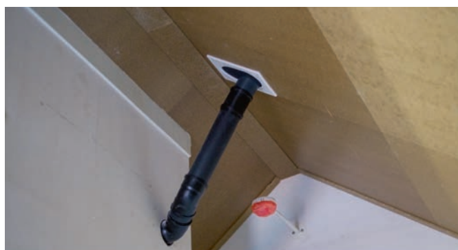
Voorbeeld: Dakdoorvoer inpandig
