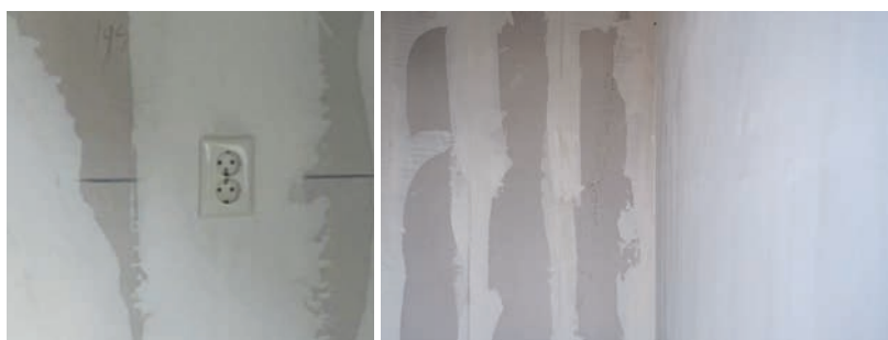
Voorbeeld: Behangklare muur (wandcontactdozen verticaal aangebracht)
